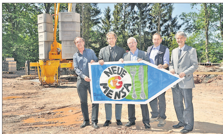
Schulleiter Helmut Schuster (r.) mit Architekten und Lehrern auf der Baustelle. Foto: Drewes
